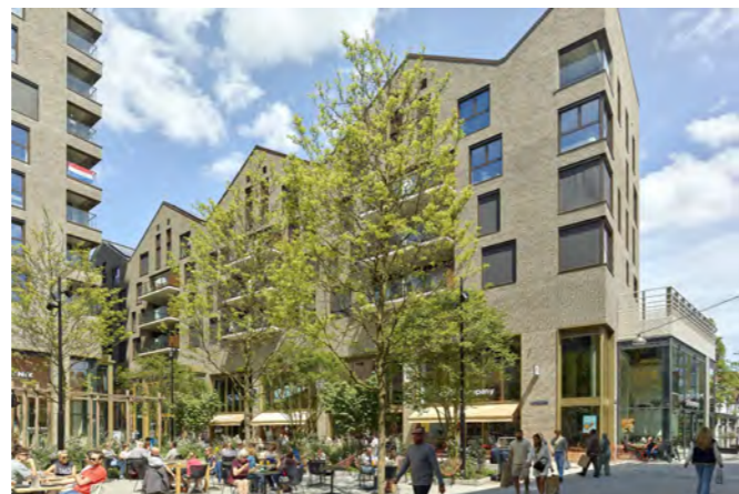
Transformatie City-Center Fotograaf: Joep Jacobs
