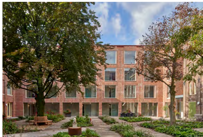
Transformatie kloostercomplex Oude Dijk Fotograaf: René de Wit
