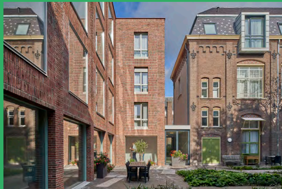
Nieuwbouw binnentuin Zusters van Liefde Fotograaf: René de Wit
